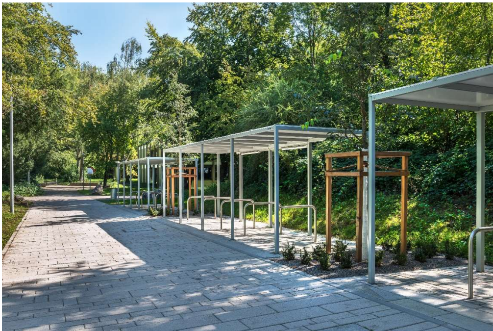
Bild VBA vom September 2023: neue Fahrradabstellanlagen nördlich Geb. 5
