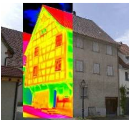
Abb. 3: Infrarot-Thermografie zum Auffinden von verborgenem Fachwerk
